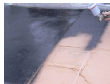
発熱塗料 施工風景
