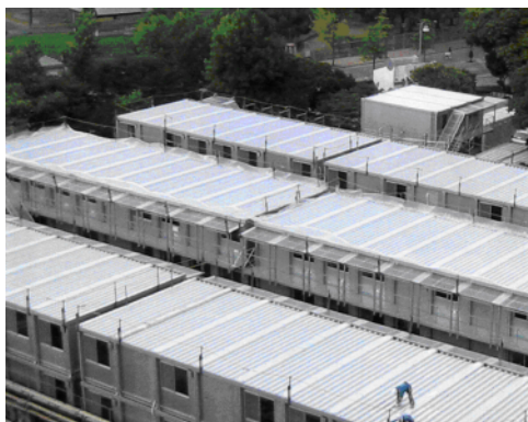
シラスバルーンペイントの施工例（国際大会競技施設）
