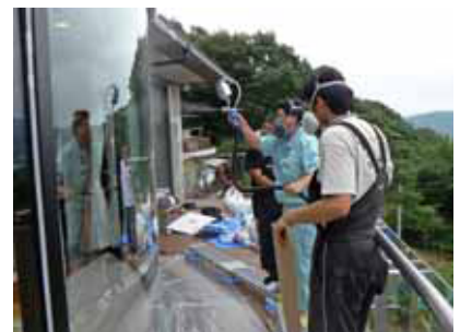
フミンコーティング風景 横10mの曲面ガラス 内側・外側施工が可能
