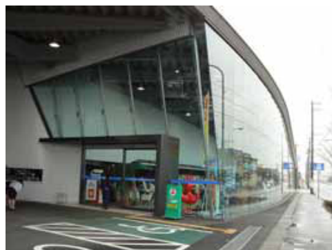
< 施工実績 > 高さ8メートル傾斜ガラス
