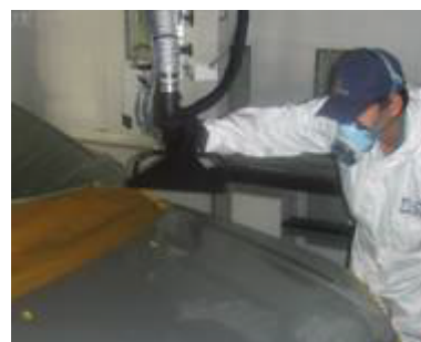
乾操作業の様子
