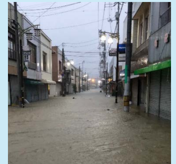
浸水により街路灯が故障
