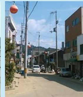
浸水によりカラー 舗装が損傷
