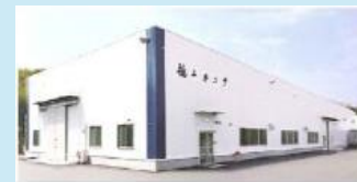
倒壊した工場・施設等の復旧支援
